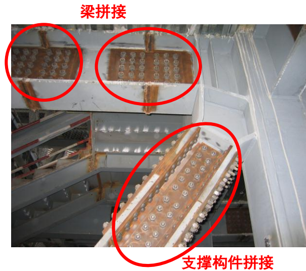
图 18 高强度螺栓连接抗剪
